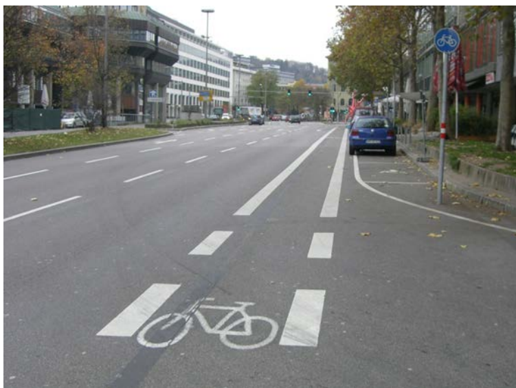
Abb. 7-5: Radfahrstreifen (Beispiel Stuttgart)
