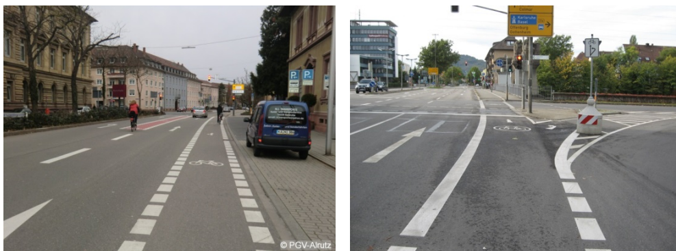
Abb. 7-13: Links: Direktes Links Abbiegen durch Radfahrstreifen (Beispiel Karlsruhe) Rechts: Indirektes Links Abbiegen mit Aufstellbereich (Beispiel Freiburg)
