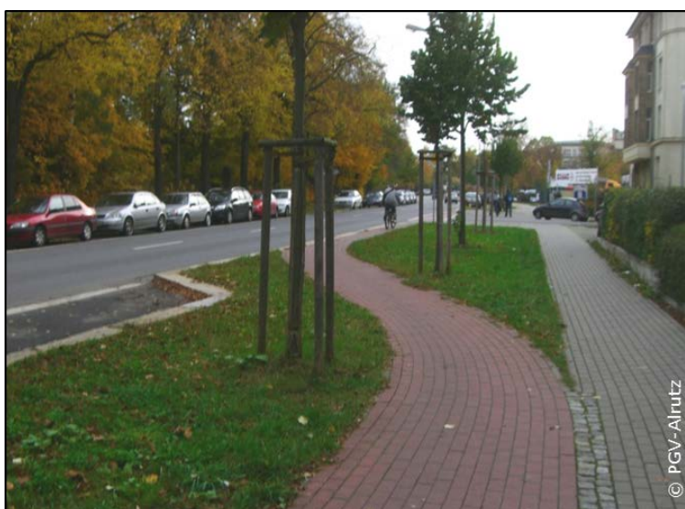
Abb. 7-9: Radverkehr wird im Vorfeld des Knotens an den Fahrbahnrand und damit ins Sichtfeld des Kfz-Verkehrs geführt (Beispiel Offenburg)
