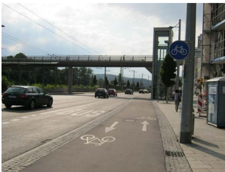
Abb. 7-4: Zweirichtungsrادweg (Beispiel Esslingen)
