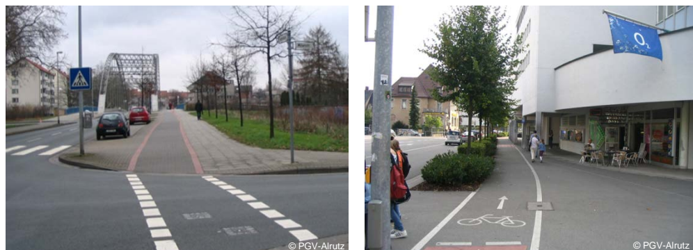
Abb. 7-3: Radwege ohne Benutzungspflicht: Baulich eindeutig (links) und Kennzeichnung durch Trennlinie und Fahrradpiktogramm (rechts)
