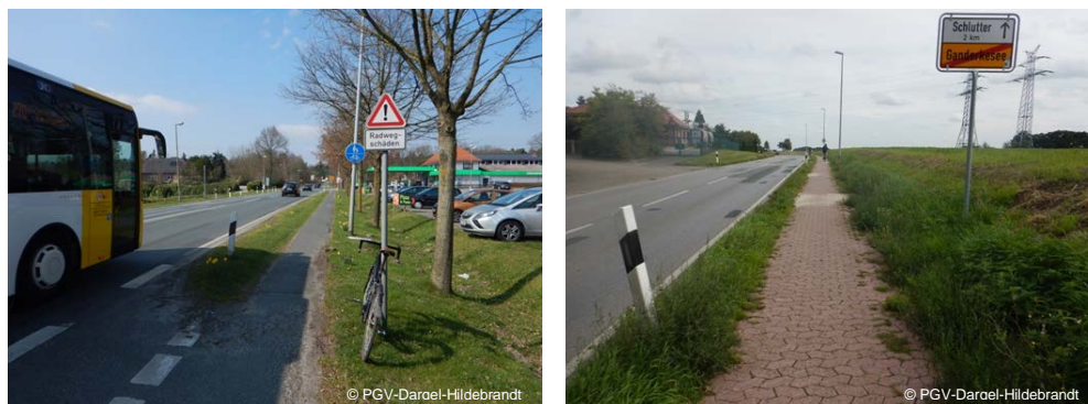
Abb. 7-18: Links: Gemeinsamer Geh- und Radweg in unzureichender Breite im Zuge der Delmenhorster Straße (L 872) in der Stadt Wildeshausen. Rechts: Gemeinsamer Geh- und Radweg in unzureichender Breite und leicht eingeschränkter Belagsqualität im Zuge des Schlutterweges (K 347, außerorts) in der Gemeinde Ganderkesee.
