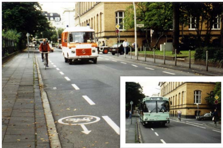
Abb. 7-6: Schutzstreifen als Schonraum für Radfahrende und als „Reservefläche“ für große Fahrzeuge (Beispiel Bonn)
