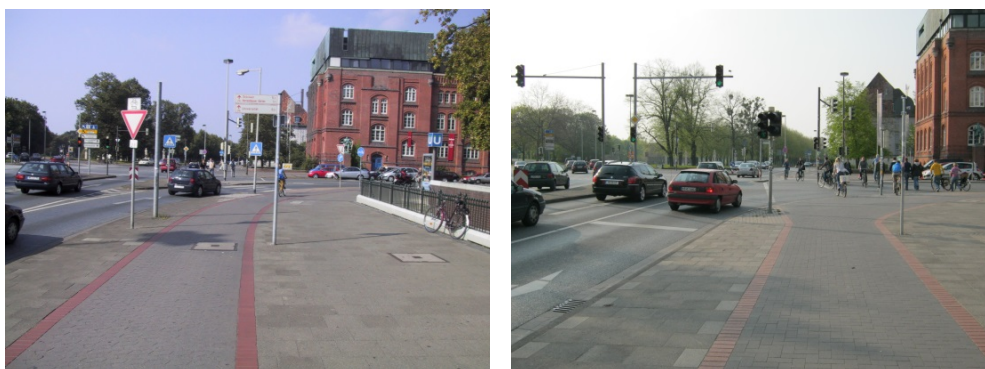
Abb. 7-11: Rückbau und Signalisierung eines konfliktträchtigen freien Rechtsabbiegefahrstreifens in Hannover (links vorher, rechts nachher)
