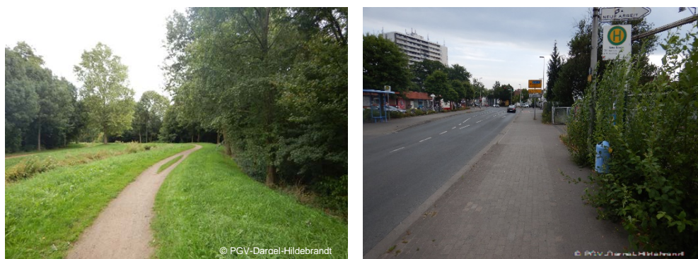
Abb. 7-20: Links: Selbständige Wegeverbindung („Im Delmegrund“) in unzureichender Breite und Belagsqualität. Rechts: Zweirichtungsradweg innerorts in nicht ausreichender Breite (Nordenhamer Straße)
