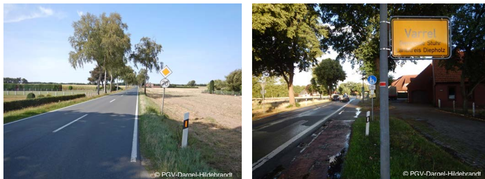
Abb. 7-17: Links: Fehlende Radverkehrsanlage bei DTV 4.200 Kfz/Tag und einem Schwerverkehrsanteil von ca. 7 % (außerorts) im Zuge der L 332 in Bassum. Rechts: Gehweg, Radverkehr frei auf einer Strecke 1. Ordnung (ungeeignete Radverkehrsanlage) in unzureichender Breite in der Gemeinde Stuhr (Varreler Landstraße, L 337)
